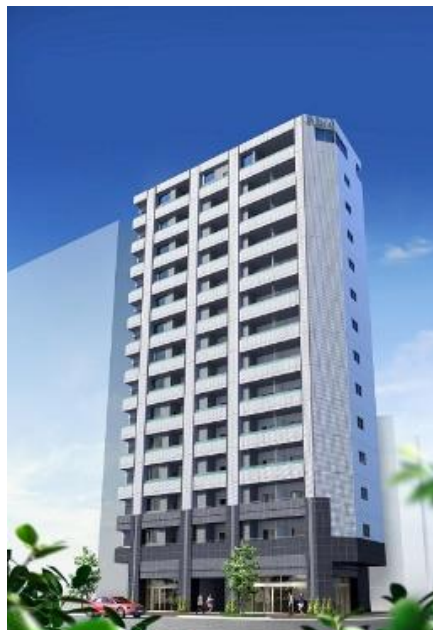
RBM築地レジデンス (外観写真に差し替え予定)
